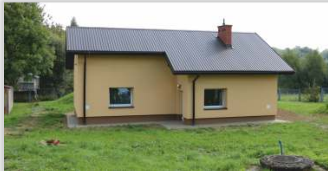
Budynek po remoncie
