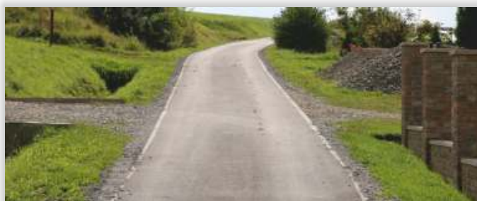
Wyremontowany odcinek drogi w Chorkówce
