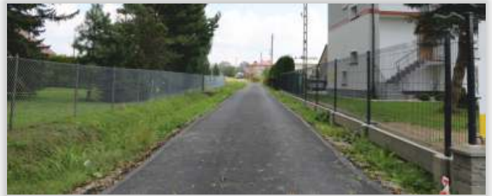
Wyremontowany odcinek drogi w Zręcinie
