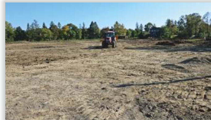
Prace przy odwodnieniu i wyrównaniu terenu
