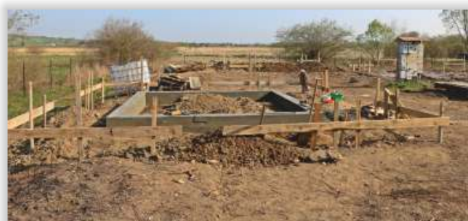
Prace przy budowie
