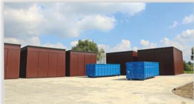
Budynek magazynowy i kontenery
