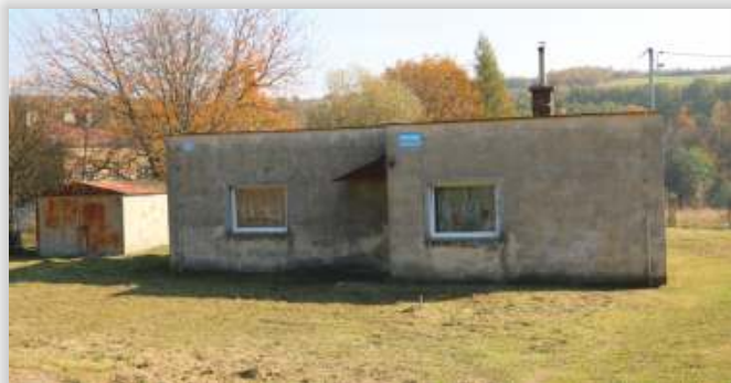
Budynek przed remontem
